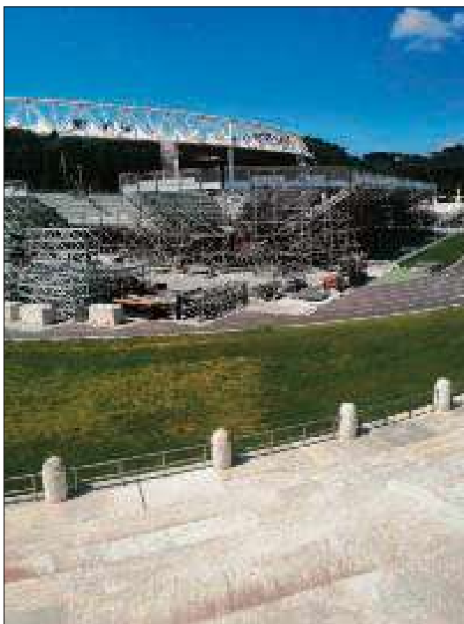
Stadio dei Marmi, lavori 4 aprile 2025
