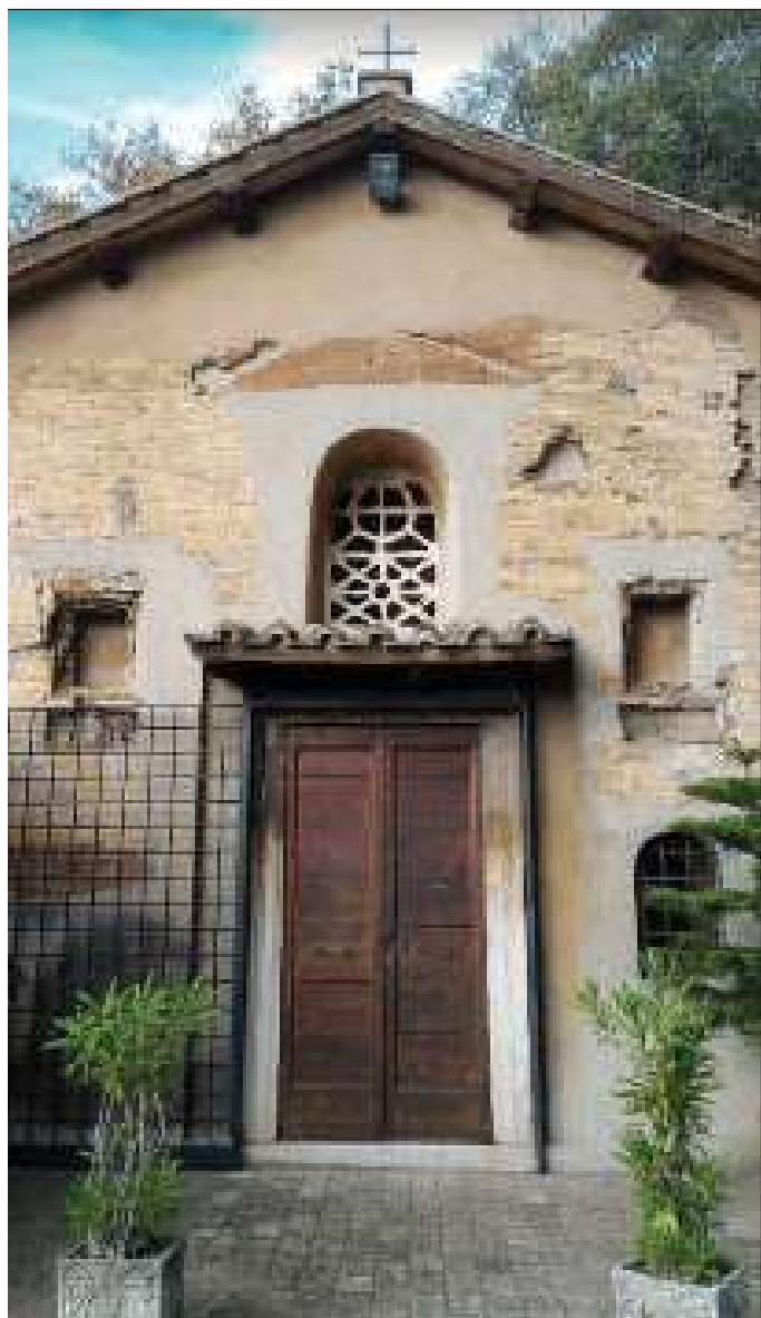
Fronte particolare portone.
