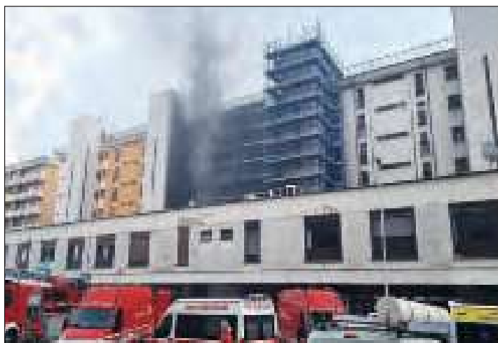
Incendio con cantiere in corso
