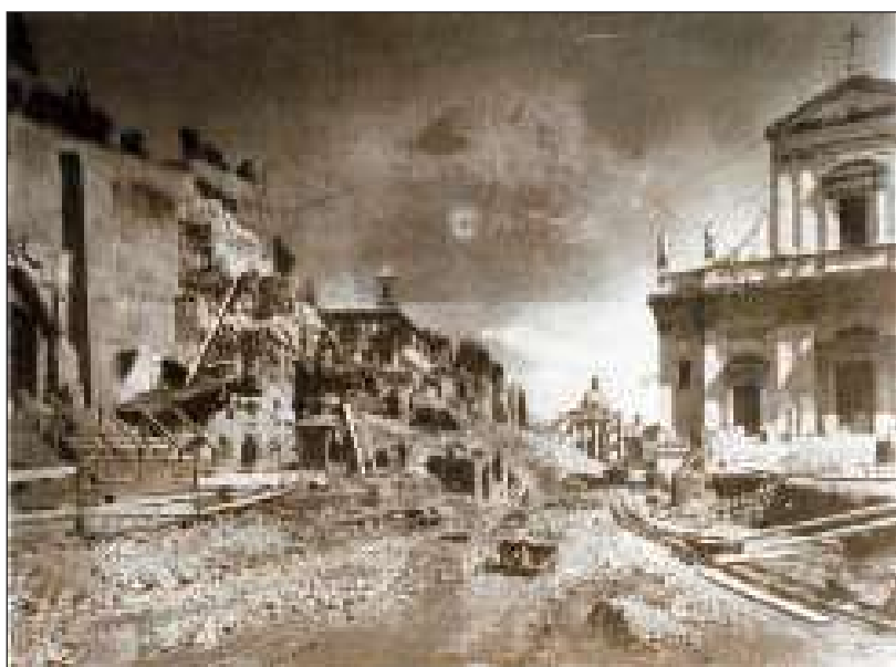
Demolizione in via della Consolazione, anni 30
