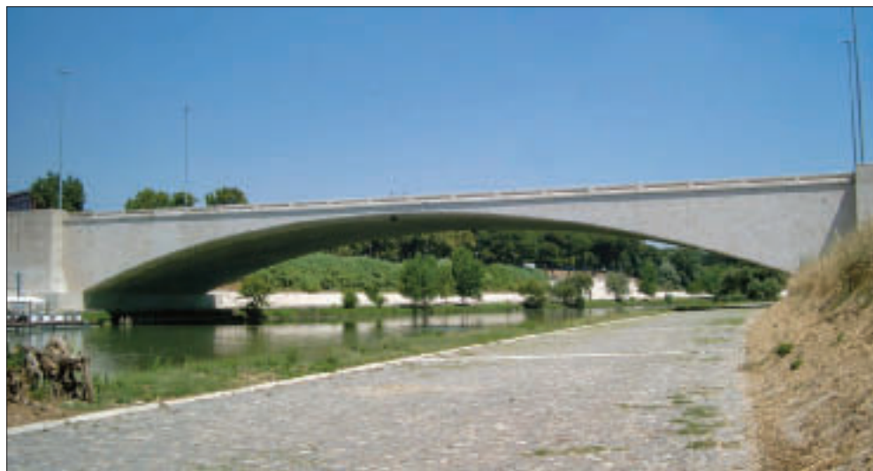
Ponte Duca d'Aosta da riva sx.
