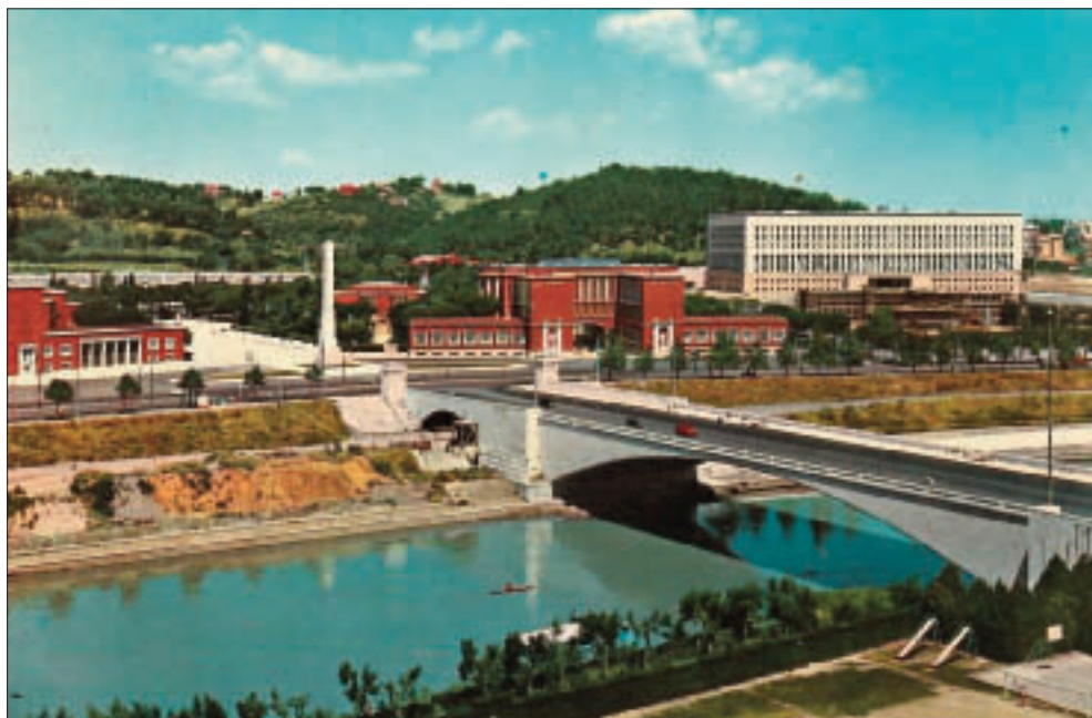
Ponte Duca d'Aosta da riva sx, 1980.
