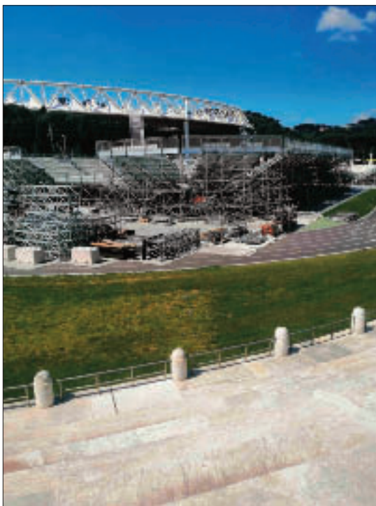
Stadio dei Marmi, lavori 4 aprile 2025
