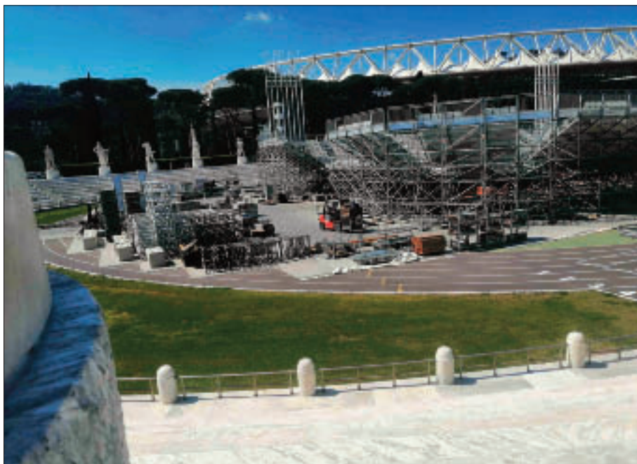
Tralicci in montaggio 4 aprile 2025
