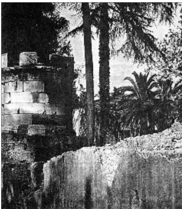
Abbattimento del muro di cinta di Villa Blanc, anni Sessanta del 900
