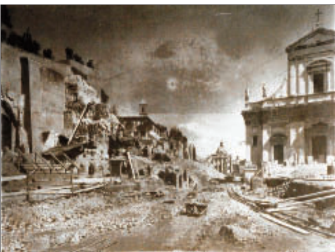
Demolizione in via della Consolazione, anni 30
