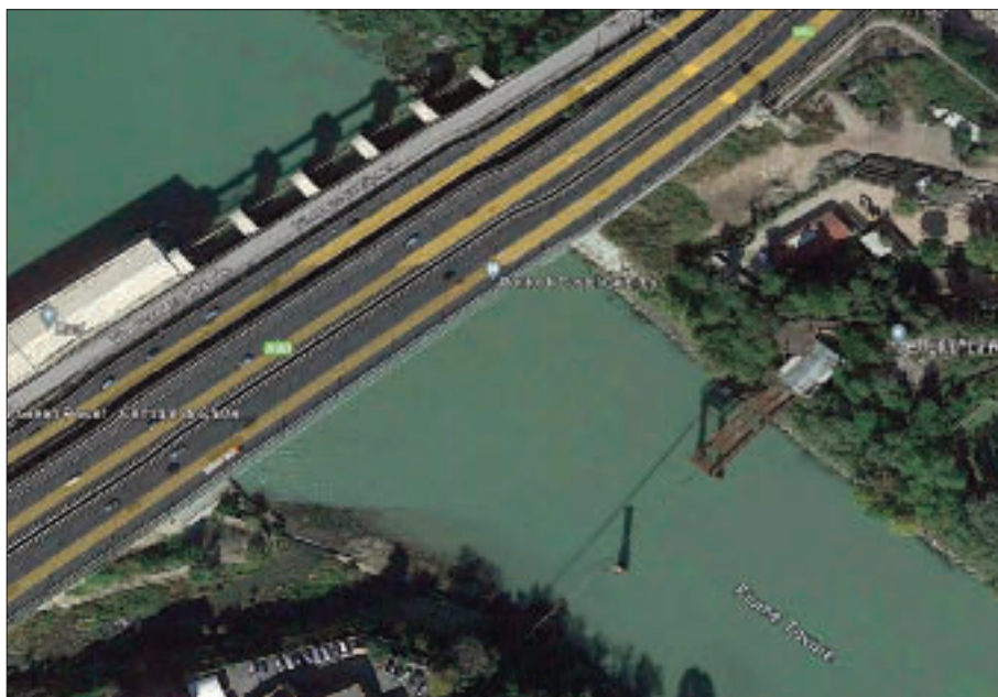
Traversa di Castel Giubileo, Autostrada GRA, rovine del Ponte di ferro e condotta idrica, 2018 da google
