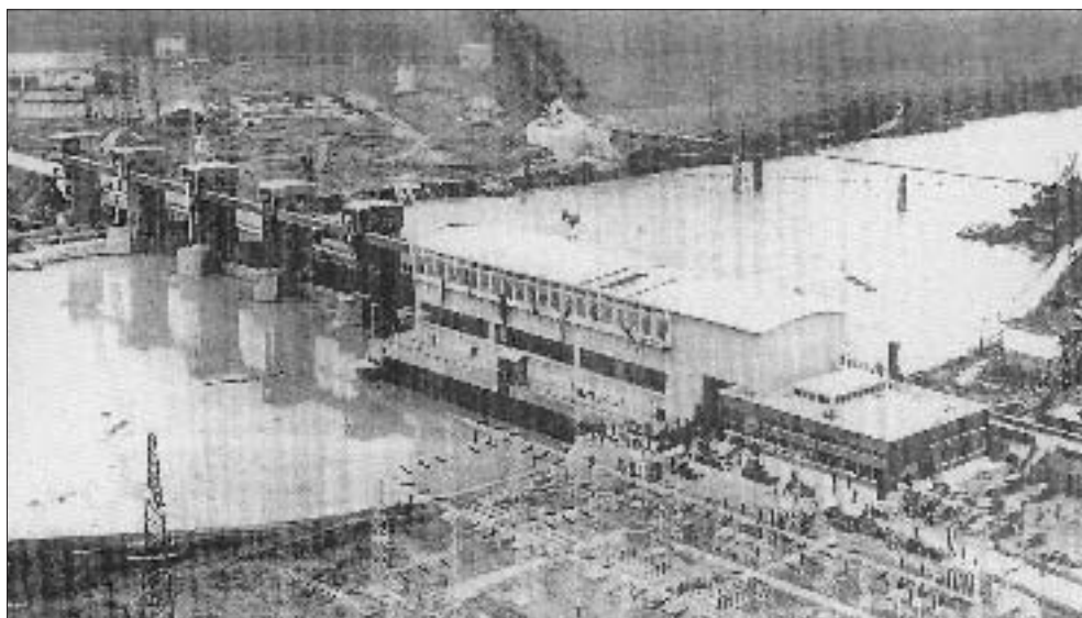
Centrale di Castel Giubileo, 12 gennaio 1951, vista da Labaro
