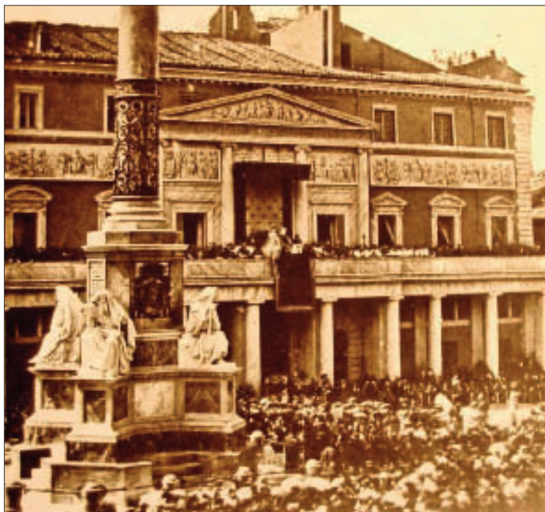
Balconata e colonnato posticci per l'inaugurazione del 1857
