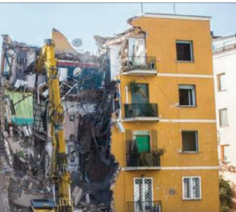
Abbattimento palazzina Farnesina, ottobre 2016.
