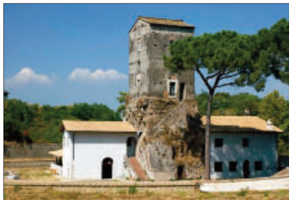
Torre Salaria, nuova edificazione.
