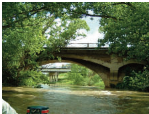
Cavo elettrico tagliato a Ponte Salario.
