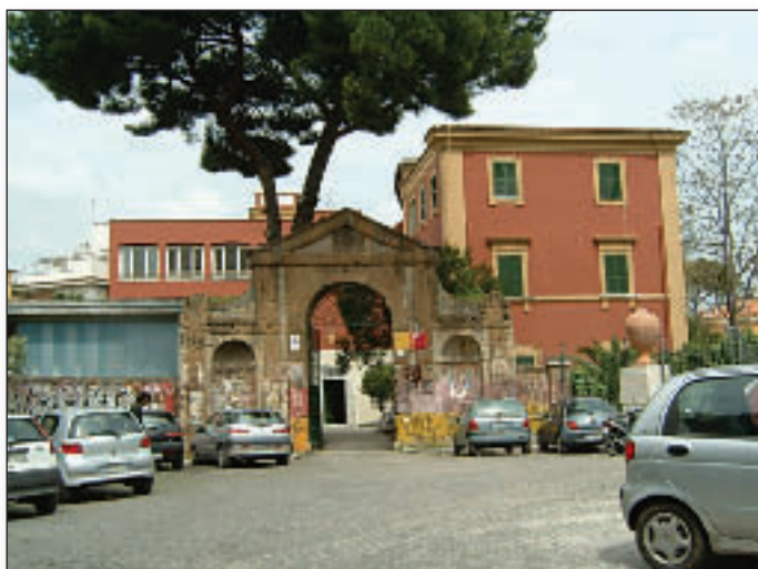
Ingresso attuale dell'ex casino nobile.
